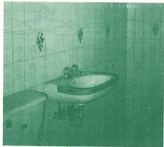
▲四 - 六樓的衛浴設備已裝好
