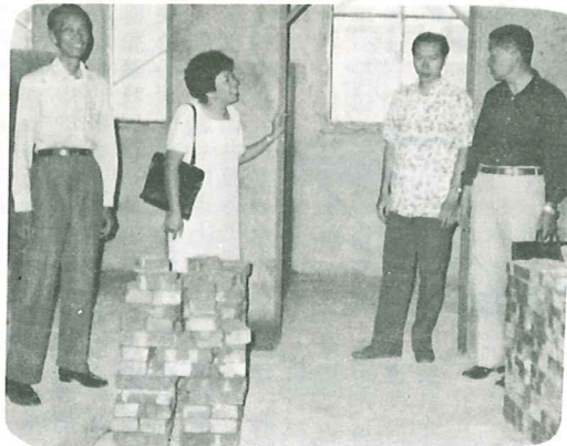
大樓內部情形
