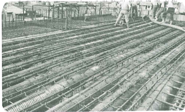
八樓樓板灌漿情形
