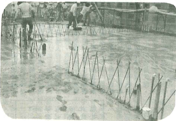
四樓板灌漿情形
